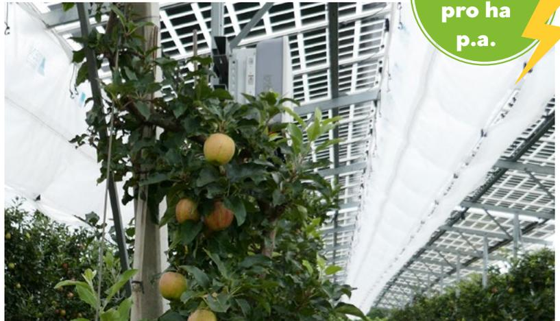
Die Agri-PV-Pilotanlage oberhalb der Apfelplantage des Obsthofs Bernhard besteht aus einem Metallgerüst, auf dem Solarmodule montiert sind. Es handelt sich um besonders stabile Alu-Edelstahl-Doppelglasmodule mit einer Transparenz von ca. 40%. Der erzeugte Ökostrom wird in das Netz des
