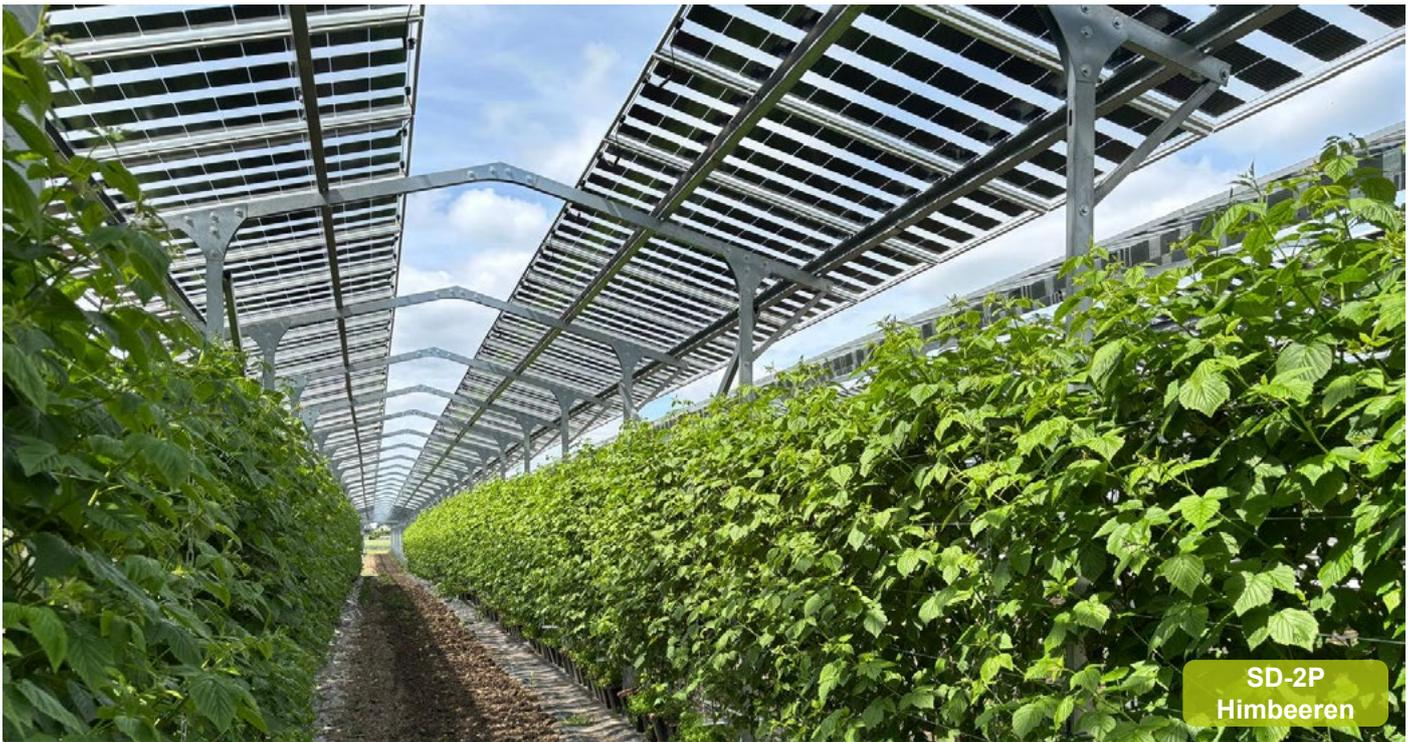
Die PV-Module bieten den darunter wachsenden Pflanzen Schutz vor extremen Wetterbedingungen wie starker Sonneneinstrahlung, Hagel und Starkregen. Mit einer Lichtbilanz von ca. 85 % wird eine optimale Balance zwischen Schutz und Lichtdurchlässigkeit gewährleistet.
