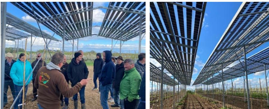
Der Lehr- und Demonstrationsbetrieb für Obstbau in Deutenkofen testet seit Ende 2023 eine AgriPV-Anlage für den Obstbau, auf der doppelverglassene Module mit 40 und 50 % Transparenz der GridParity AG installiert sind. Dies stößt bei Besuchern aus dem In- und Ausland auf große Begeisterung.
