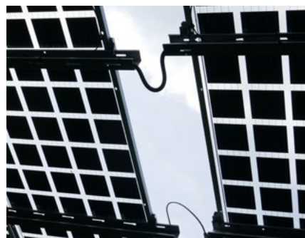
Einfache elektrische Verbindung der Modultische
