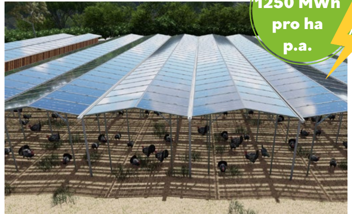
1,1 ha Hühnerfreigehege mit Stall und Wasserführung: 5 m Reihenabstand, 1.100 kWp/ha
