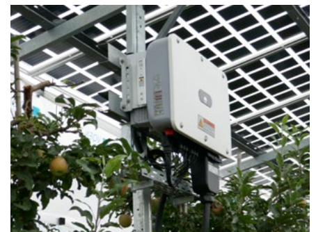
Sichere Montage von Wechselrichtern
